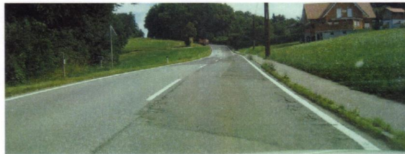
Über ein Kilometer der B65 wird in Kainbach bis Dezember saniert
